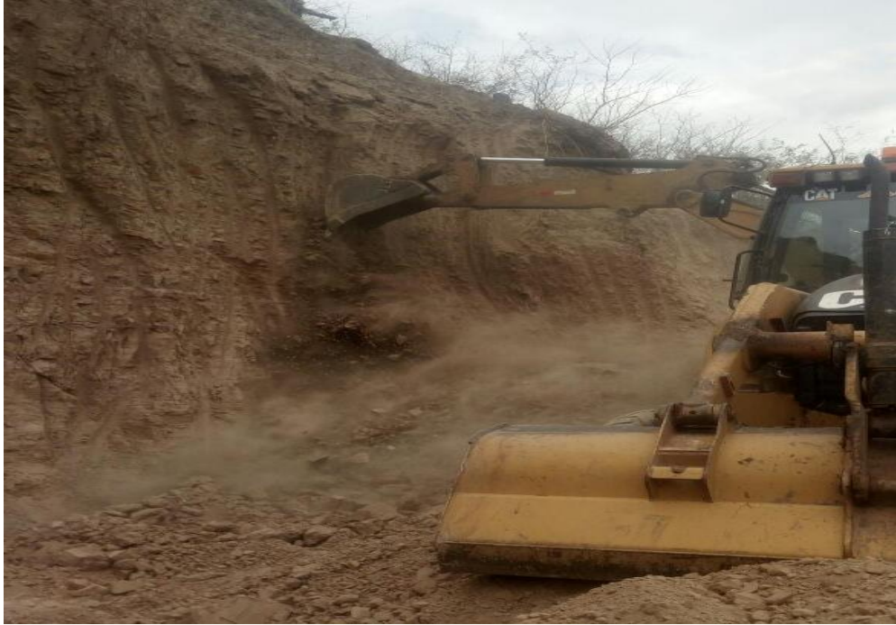
Extracción de material de cantera
