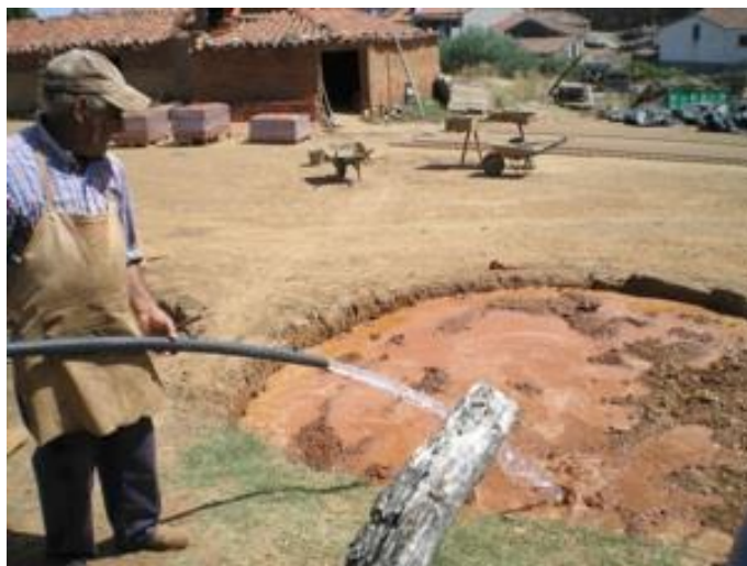
Figura II-5: Preparación de masa para ladrillo
