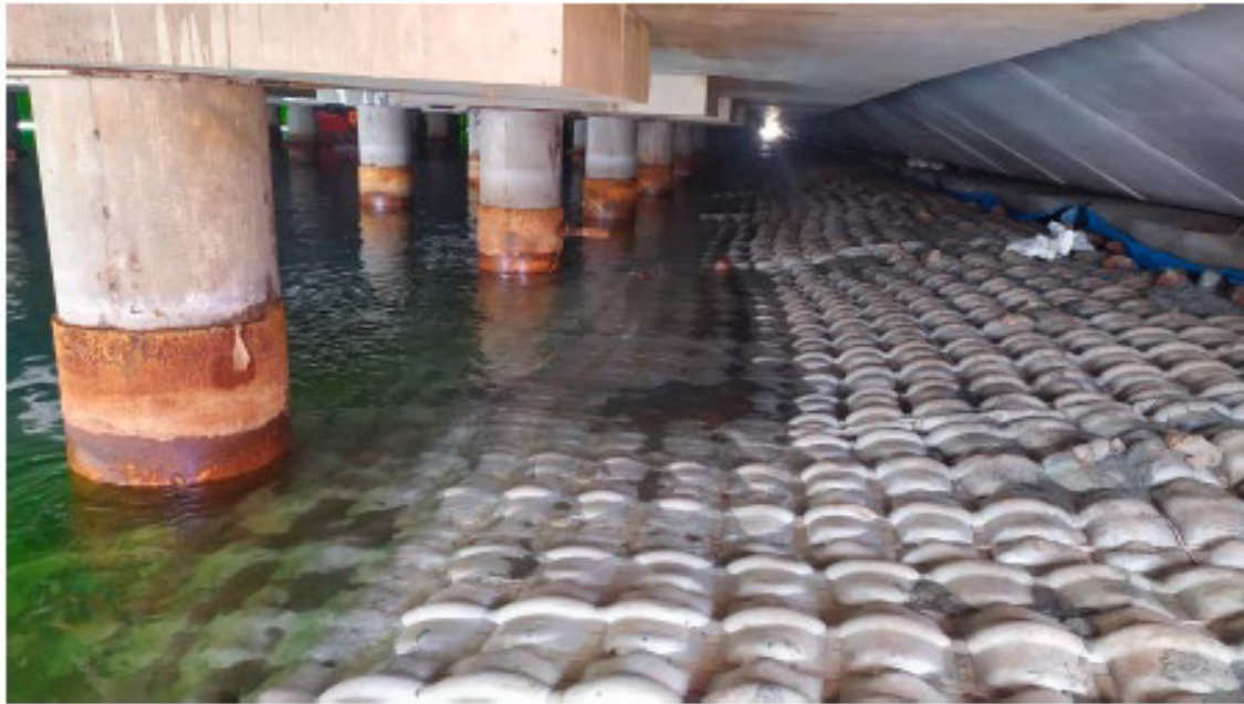
Fotografía 1: Instalación de colchacreto en talud de muelle
