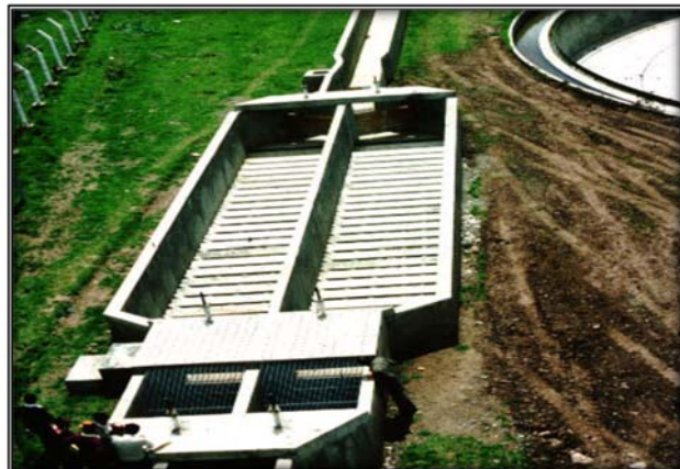
Figura N° 2.18. Desarenadores de flujo horizontal en paralelo
