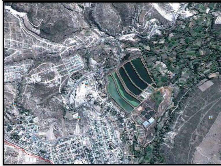
Figura N° 2.7. Vista Panorámica de la PTAR de “La Tatora”.
