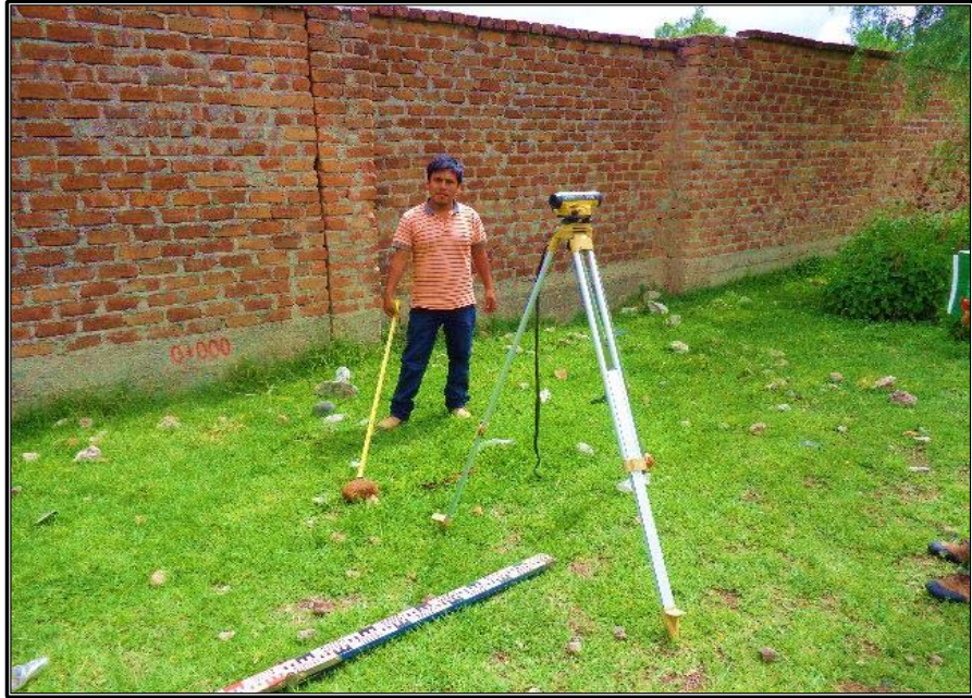
Fotografía N° 01: Inicio del Levantamiento Topográfico en la PTAR proyectado.
