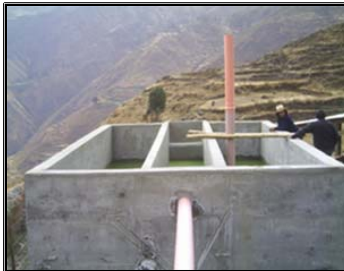
Figura N° 2.21. Tanque Imhoff en zonas rurales.
