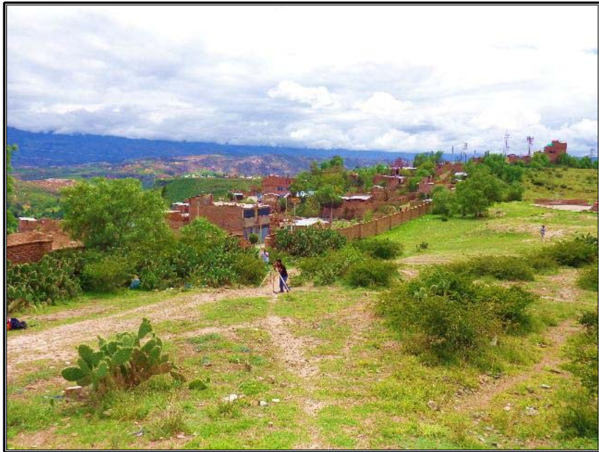
Fotografía N° 02: Levantamiento Topográfico para la Línea de Impulsión.
