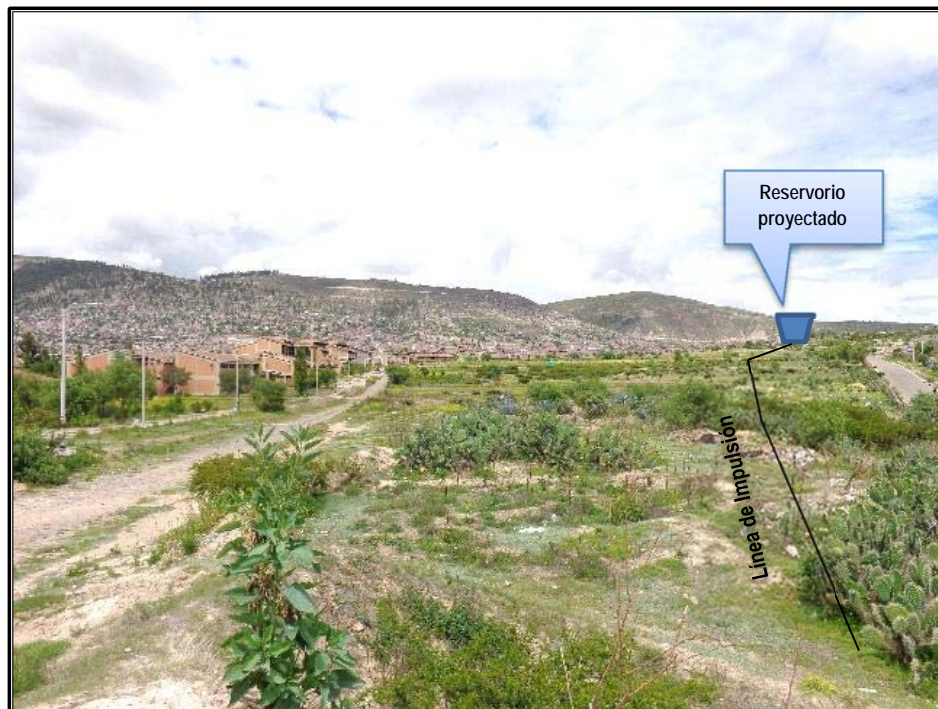
Fotografía N° 04: Vista Panorámica de la Línea de Impulsión de la PTAR hacia el Reservorio.
