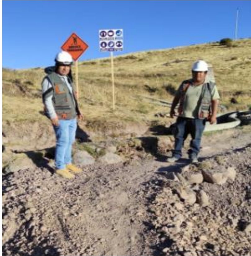
Anexo 8: Supervisión a la señalización de la obra
