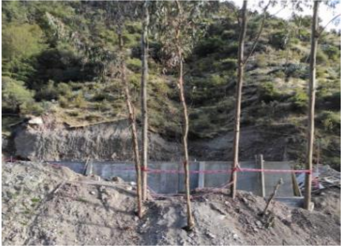
Anexo 9: delimitación de los trabajos
