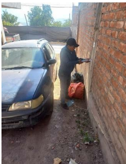
Fotografía 3. Prueba de esclerómetro en columna Fuente: Propia
