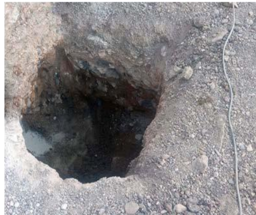
Ilustración 11. Excavación para la muestra de suelos
