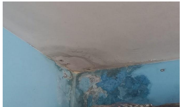
Ilustración 18. Casa 1- rajadura en cielo raso del primer nivel. Fuente: Propio
