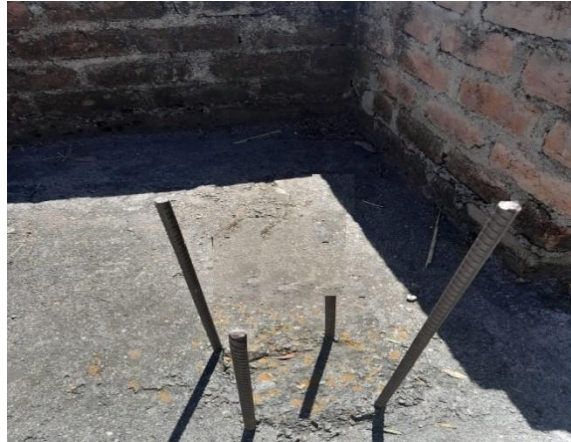
Ilustración 22. Vivienda 1- mechas del fierro de las columnas Fuente: Propia
