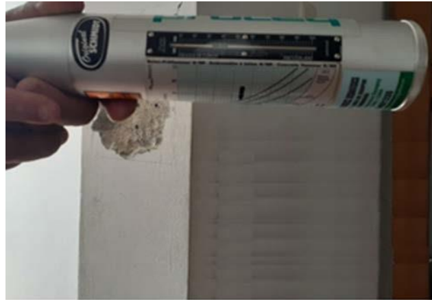
Fotografía 5. Prueba de esclerómetro en columna Fuente: Propia
