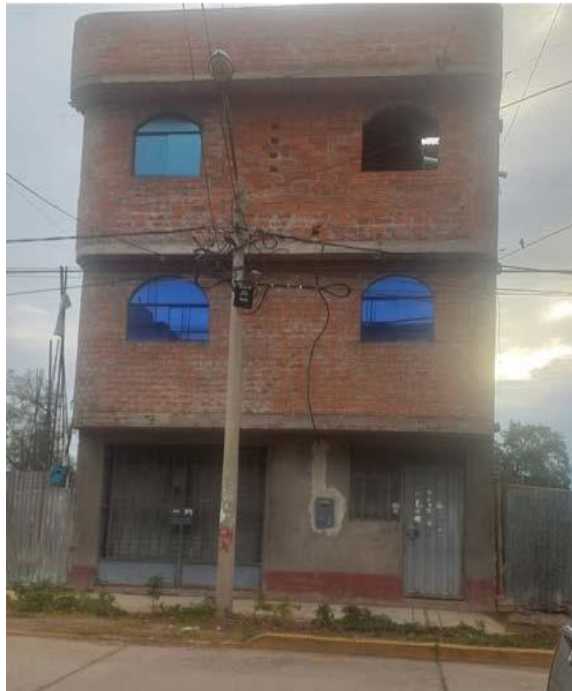
Fotografía 2. Vivienda 2- Prueba de esclerómetro en viga peraltada Fuente: Propia
