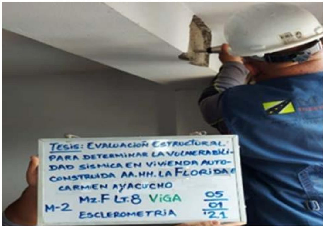
Fotografía 1. Evaluación Estructural Fuente: Propia
