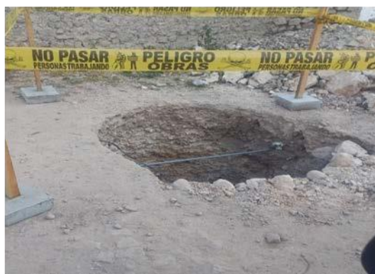
Ilustración 12. Excavación para muestras de suelos
