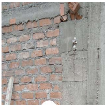
Ilustración 23. Casa 2- vaciado de columna Fuente: Propia
