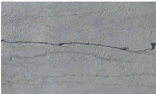
Ilustración 18. Casa 1- rajadura en cielo raso del primer nivel. Fuente: Propio
