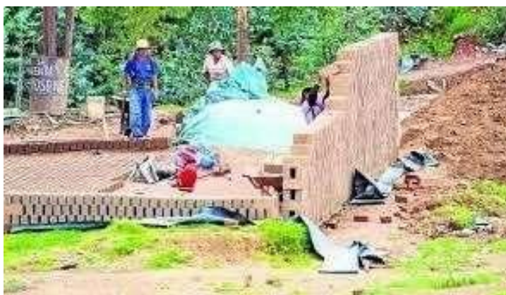
Figura IV-5: Vista panorámica de la ladrillera II
