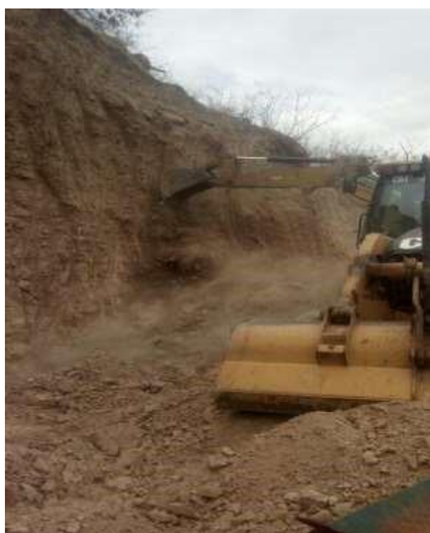
Figura V-8: Extracción de arcillas con maquinaria
