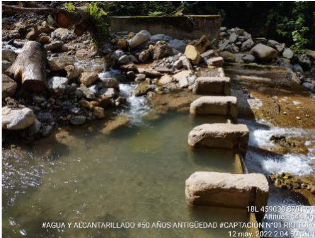
Fotografía 3 Se observa el estado situacional de fuente de agua Fecha: Nov-21
