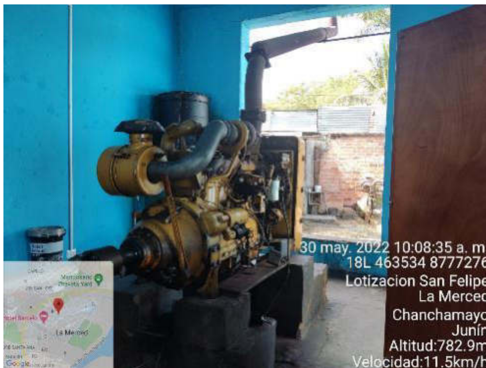
Fotografía 8 Se observa inspección técnica de planta de bombeo.
