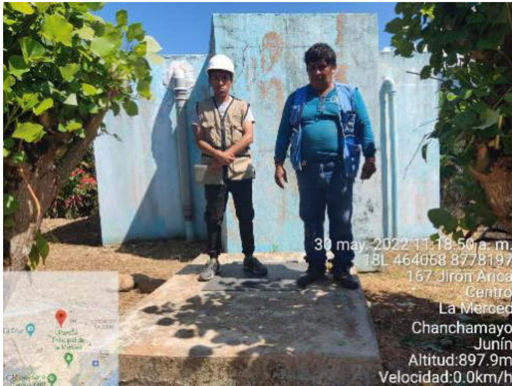
Fotografía 9 Se observa el reservorio N° 03 del sistema de agua potable.
