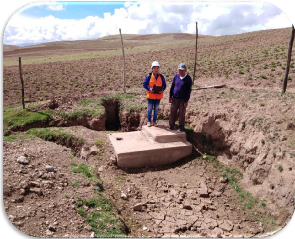
FOTO 7: Captación del sistema 2 "Antacocha"
