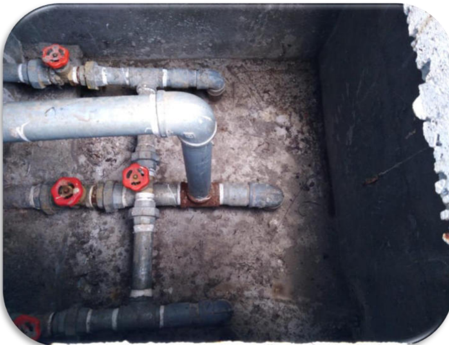
FOTO 10: Evaluación de caja de válvulas
