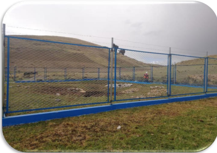
FOTO 1: Captación en ladera “Antuyo”
