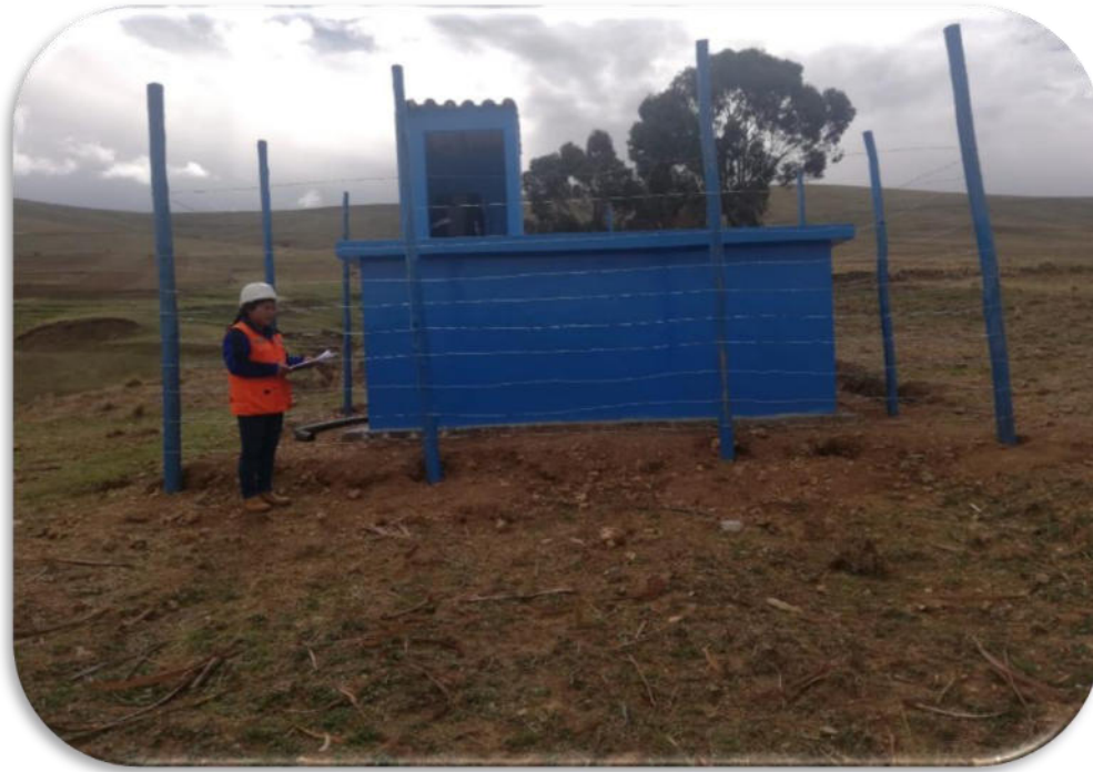
FOTO 3: Evaluación del Reservorio del Sistema 1
