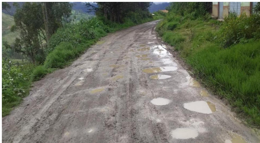
Fotografía 21. Fotografía de la situación de la carretera (Km. 2+416)
