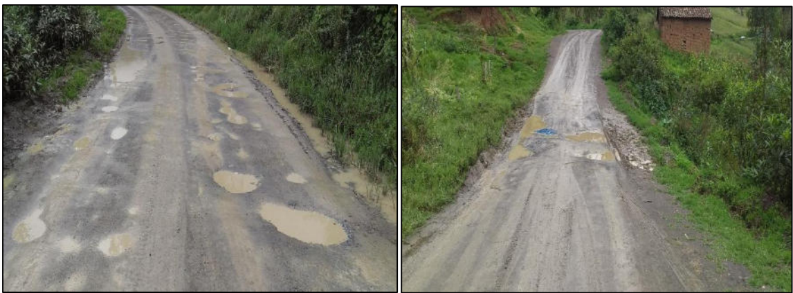
Fotografía 20. Fotografía de la situación de la carretera (Km. 1+297 - Km. 1+476)
