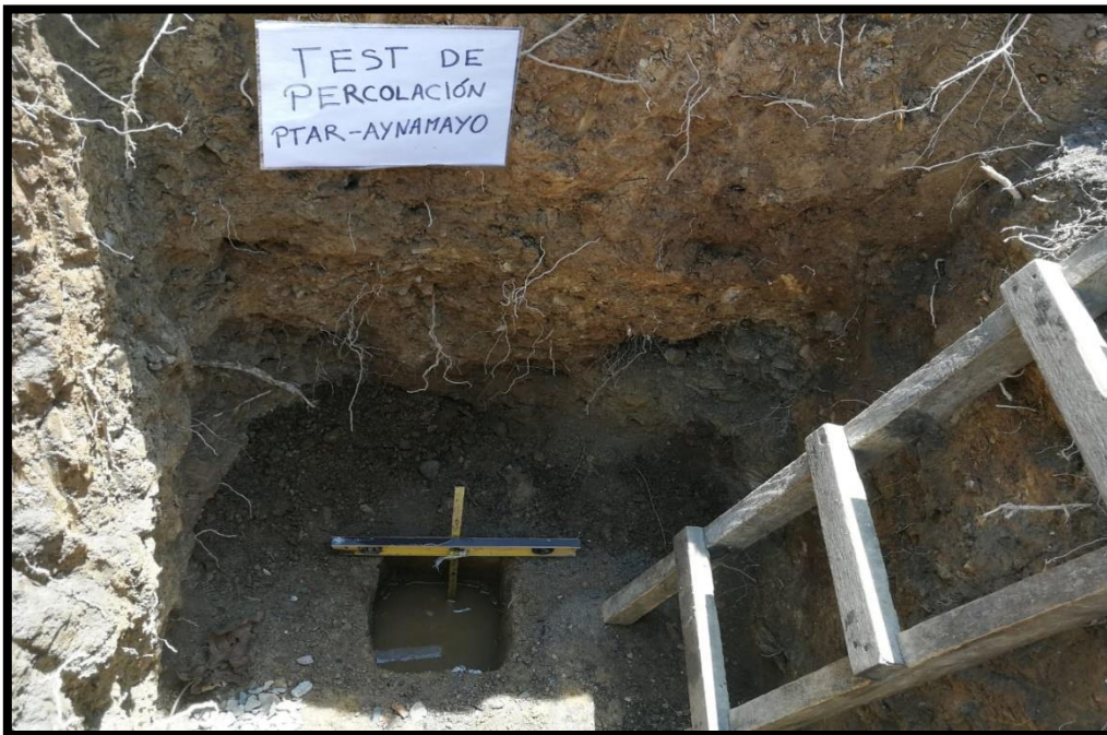
FOTOGRAFIA Nº 24- Test de Percolación para la Planta de Tratamiento - Aynamayo
