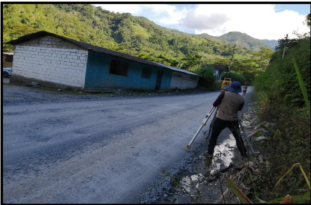
FOTOGRAFIA N° 14- Levantamiento Topográfico de la Vía por donde ira la Red Colectora
