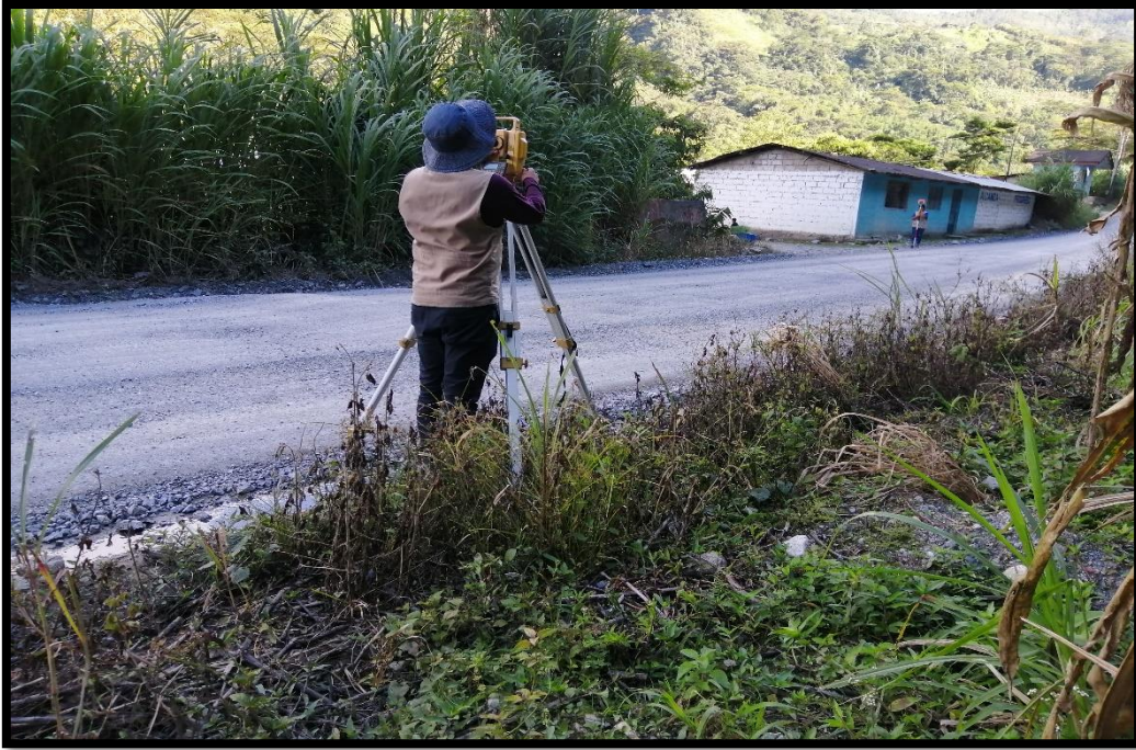
FOTOGRAFIA N° 13- Levantamiento Topográfico de la Vía por donde ira la Red Colectora
