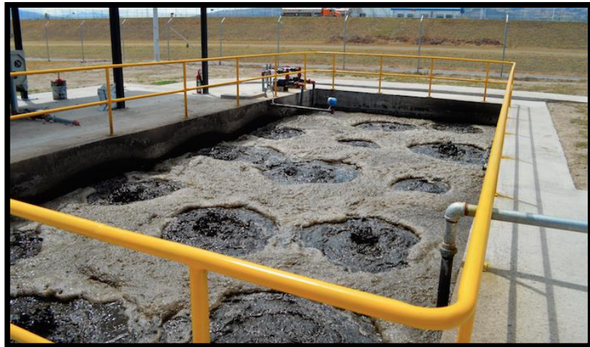
Figura: 2.9 Aireación de Lodos Activados
