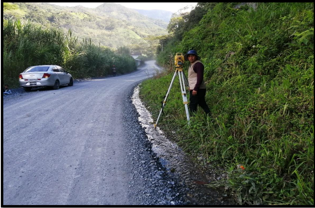
FOTOGRAFIA Nº 11- Levantamiento Topográfico de la Vía por donde ira la Red Emisora
