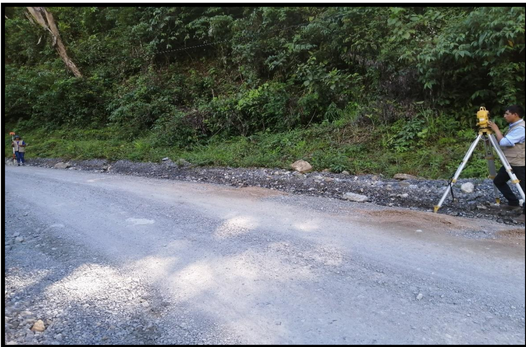
FOTOGRAFIA Nº 10- Levantamiento Topográfico de la Vía por donde ira la Red Emisora
