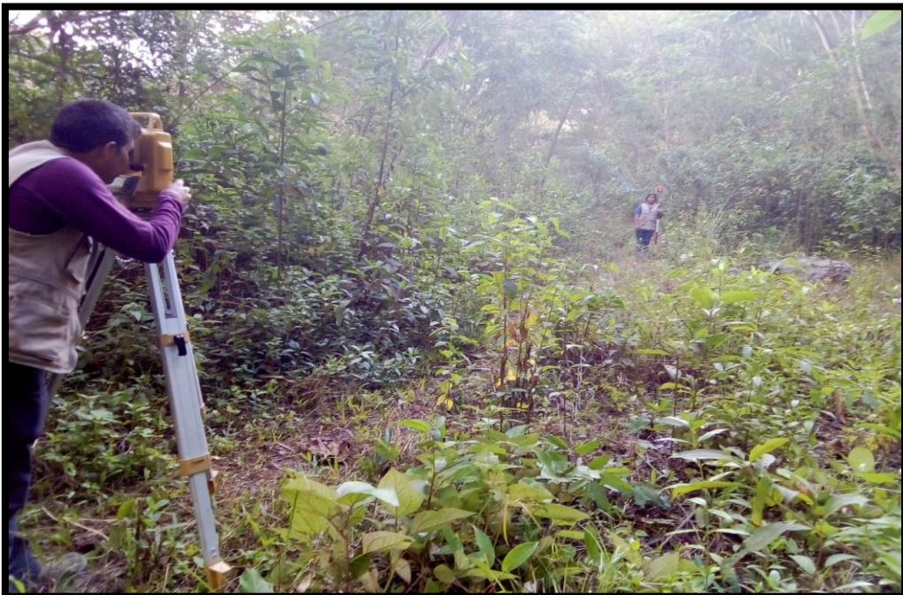
FOTOGRAFIA N° 20- Levantamiento Topográfico en la Ubicación de La Planta de Tratamiento de Aguas Residuales
