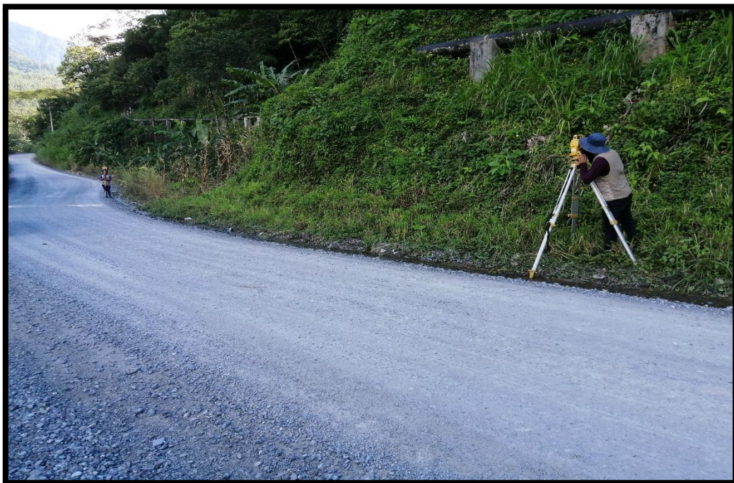
FOTOGRAFIA Nº 12- Levantamiento Topográfico de la Vía por donde ira la Red Emisora
