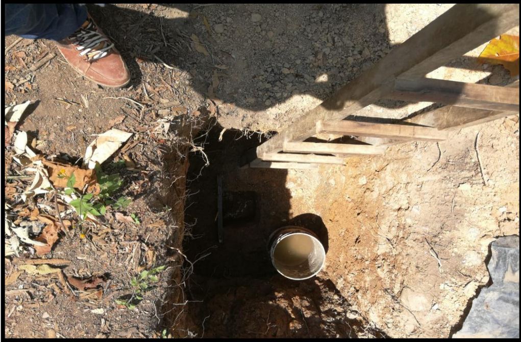
FOTOGRAFIA N° 25- Tés de Percolación en la Ubicación de La Planta de Tratamiento de Aguas Residuales
