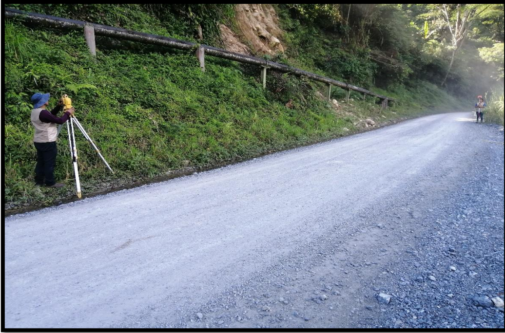
FOTOGRAFIA Nº 9- Levantamiento Topográfico de la Vía por donde ira la Red Emisora
