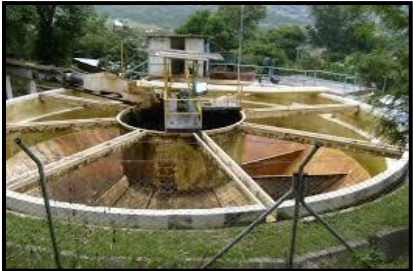
Foto: 2.10 Sedimentador tipo Dortmund
