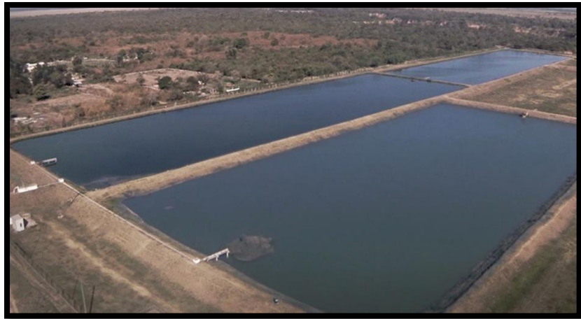
Foto: 2.6 Laguna de Estabilización
