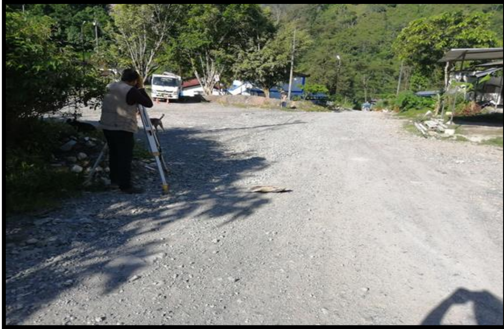
FOTOGRAFIA Nº 17- Levantamiento Topográfico en el Pueblo de la Red Colectora
