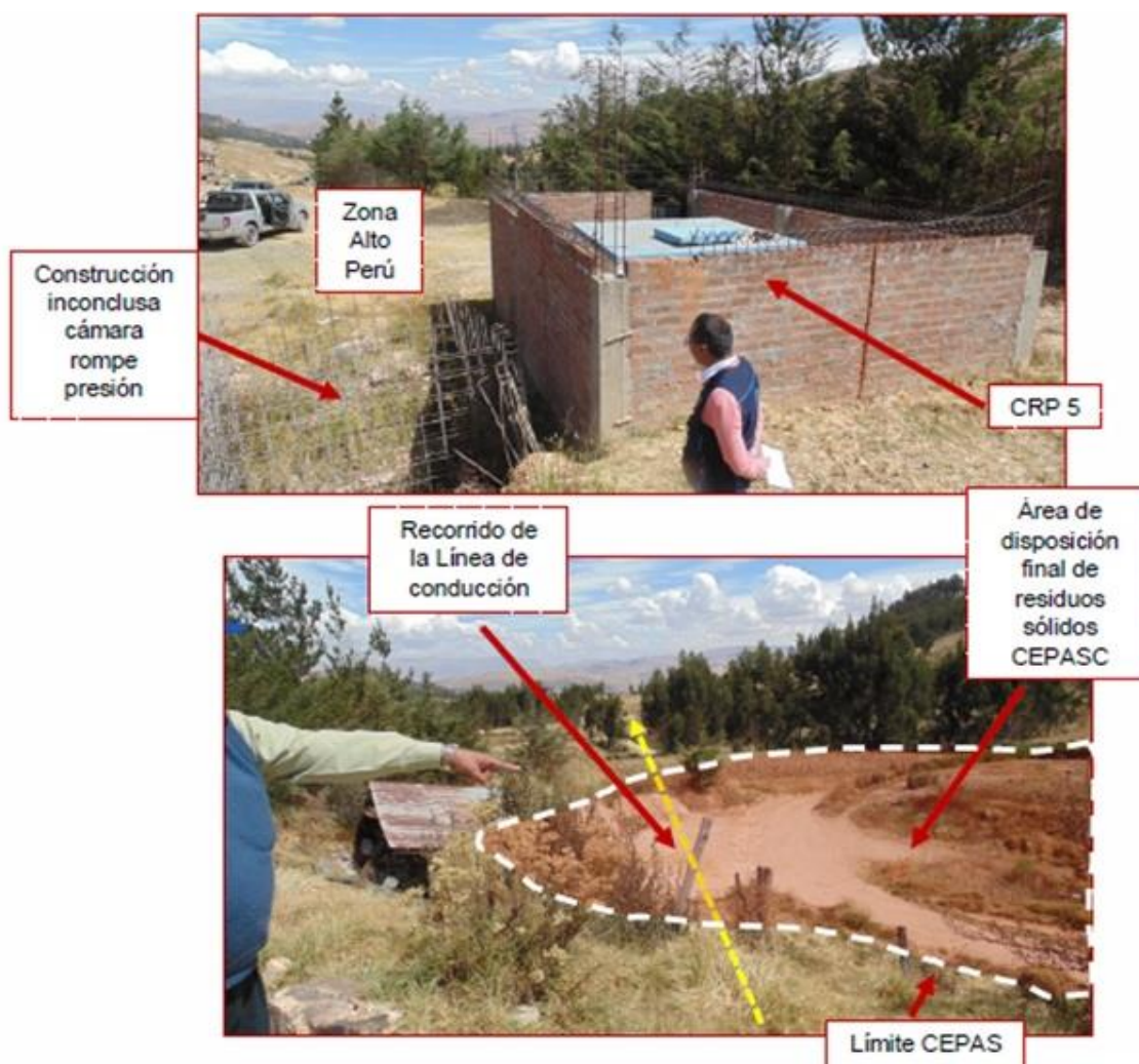
Figura 35: Cámara Rompepresión-Alto Peru
