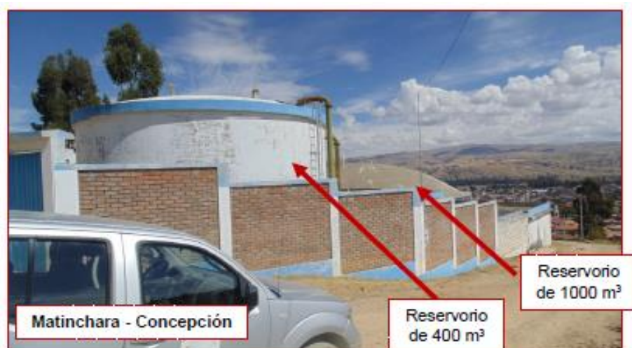
Figura 36: Reservorios – Sistema de Agua Potable
