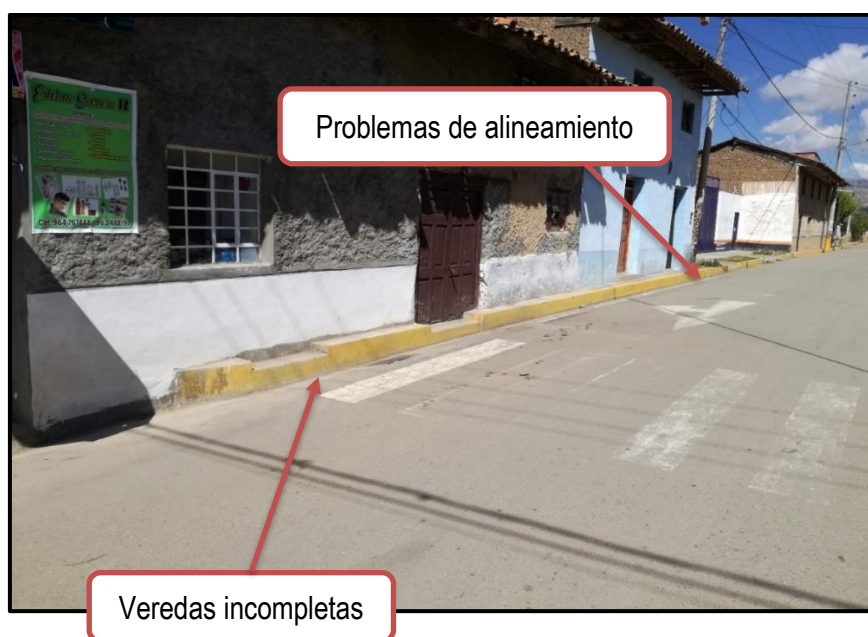
Figura 14: Veredas incompletas - problemas de alineamiento
