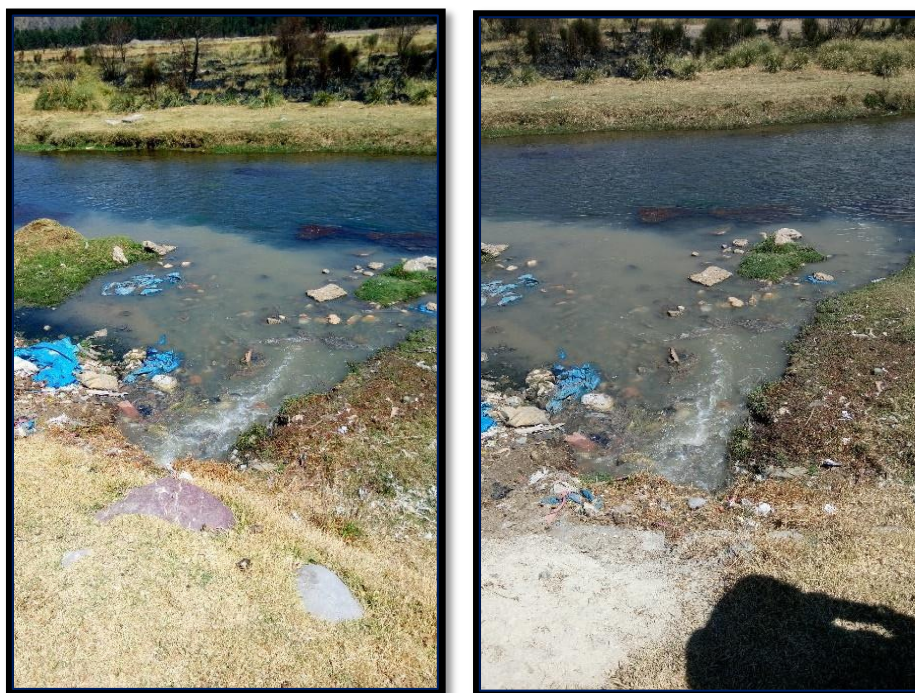
Figura 42: Emisor “Cáceres” cerca de la PTAR – Sistema de AS
