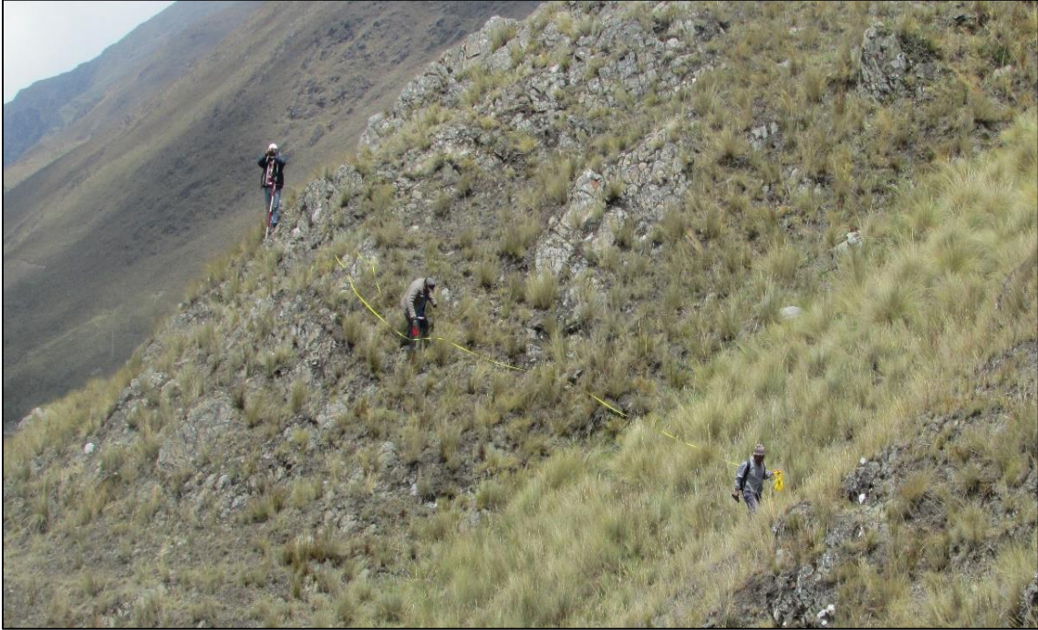
Fotografía 15: Trabajos de colocación de progresivas
