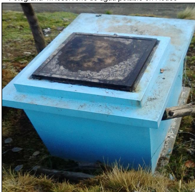
Fotografía 4:Reservorio de agua potable en Rodeo
