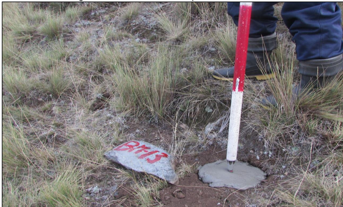
Fotografía 22: Monumentación de BMs para el control de nivelación
