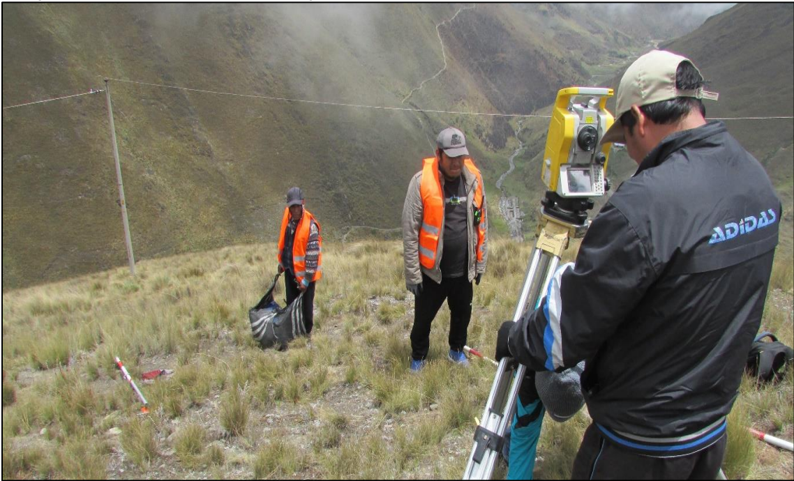
Fotografía 16: Instalación de equipo topográfico estación total
