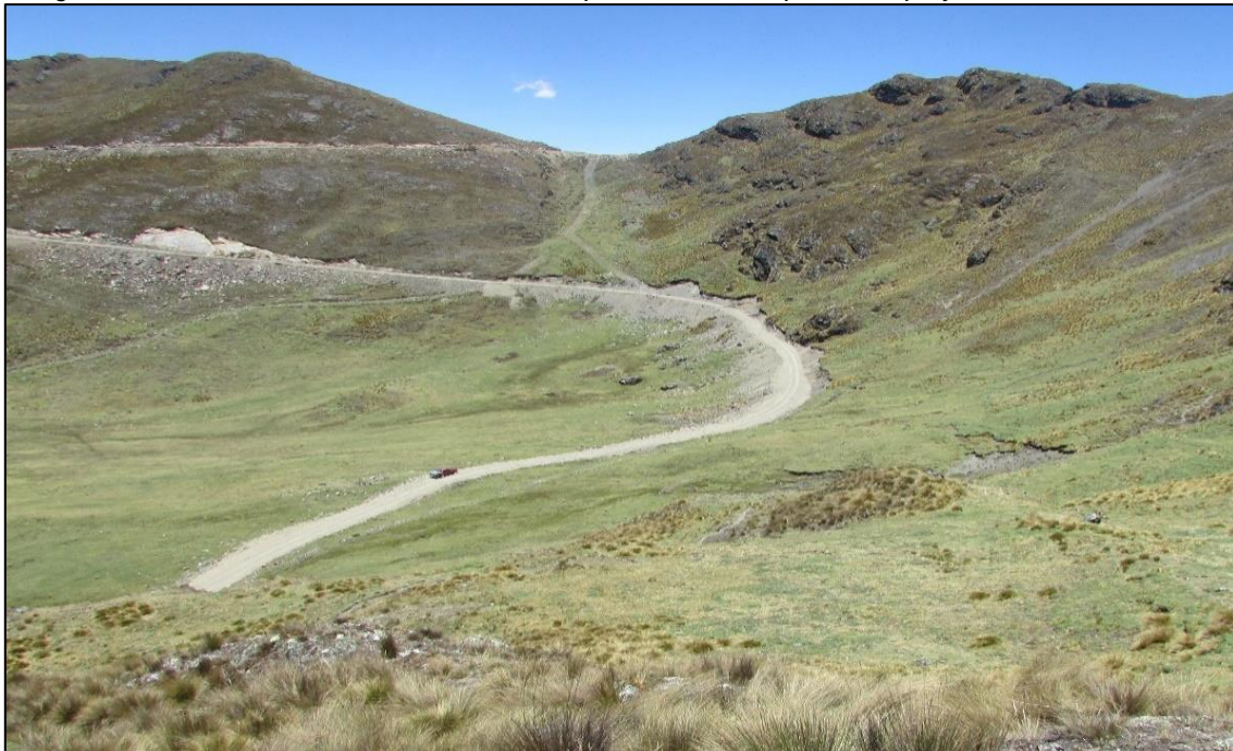
Fotografía 26: Vista del camino existente AY-583, punto final de empalme del proyecto
