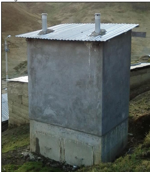
Fotografía 5: Letrinas sanitarias domiciliarias en Rodeo
