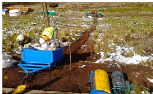
Fotografía N°2 Acarreo de materiales mecanizado
