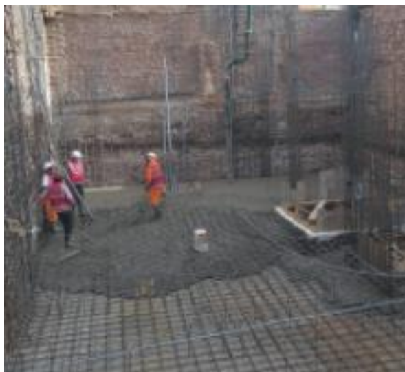
Fotografía 6: Construcción N°3 - Supervisión de trabajos
