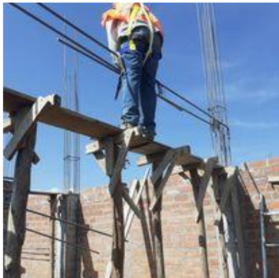
Fotografía 3: Construcción N° 2 trabajos en altura
