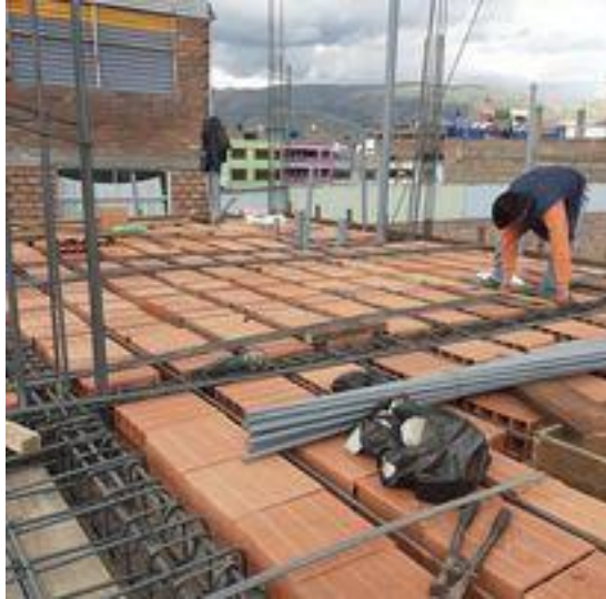
Fotografía 2: Condiciones de trabajo de la construcción N° 1
