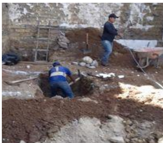
Fotografía 1: Construcción N°1 excavación y movimiento de tierra
