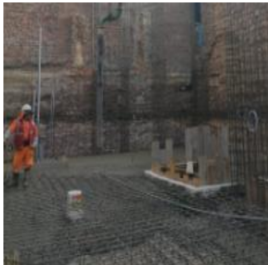
Fotografía 5: Construcción N°3 - Personal con EPPs completos
