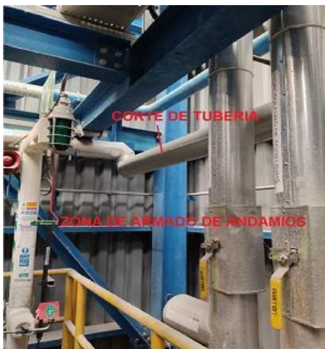
Fotografía 4. Imagen de zona de corte de tubería y armado de andamios
