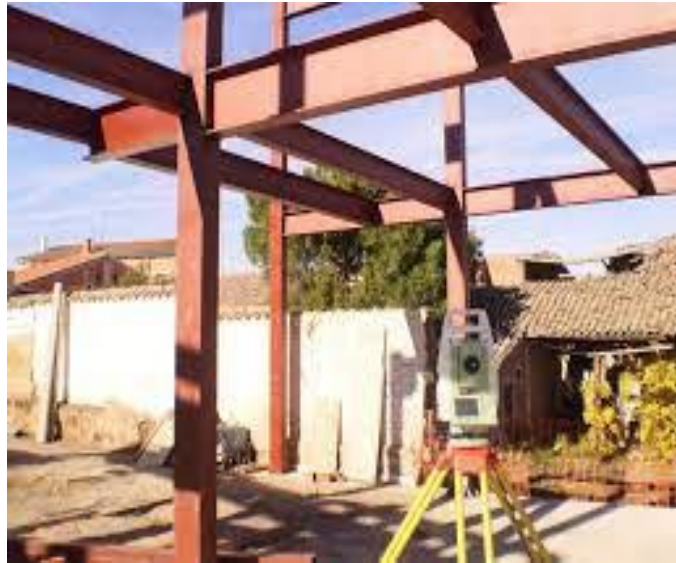
Figura 3. Imagen de verticalidad Estructuras Metálicas
