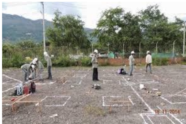
Figura 10. Imagen de trazo y replanteo topográfico
