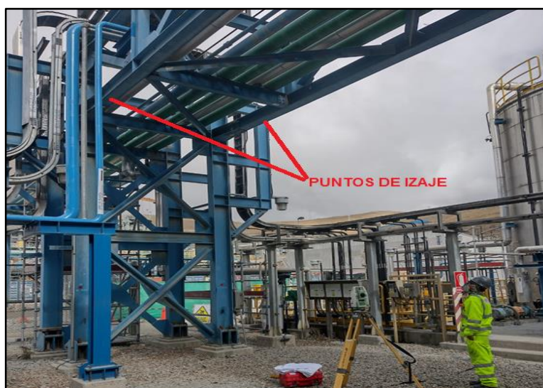
Fuente: MMG Las Bambas – rigging plan – topografía
