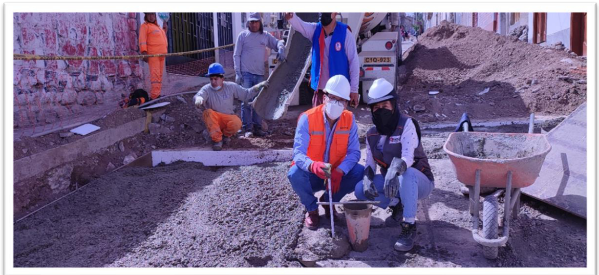
Imagen 4: Muestreando el asentamiento del concreto.
