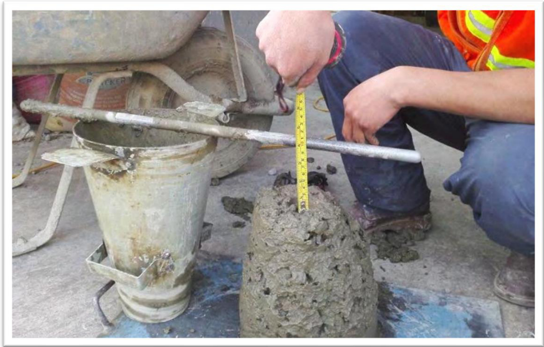
Imagen 5: Control de asentamiento de concreto.
