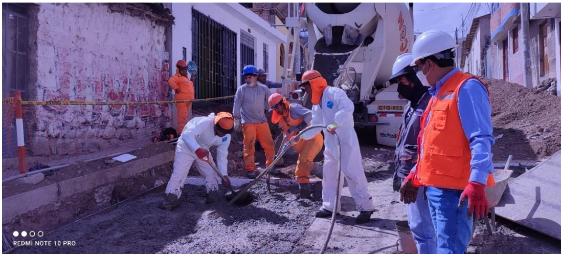
Imagen 6: Colocación y vibrado de concreto
