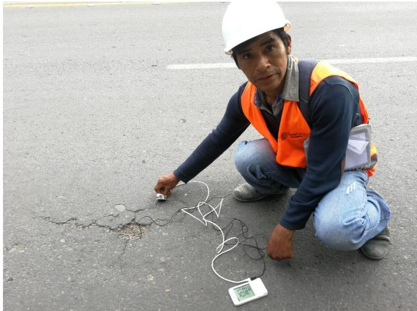
**Fotografia N°19:** Fallas del pavimento de la carretera central margen izquierda
