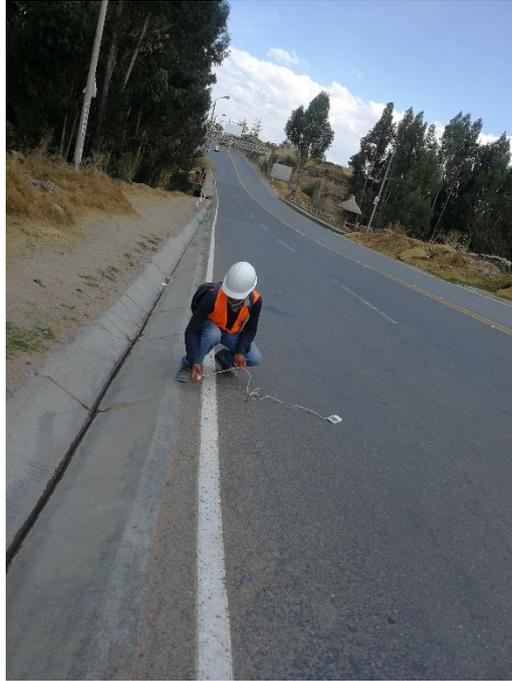
**Fotografia N°13:** Lectura de data de la temperatura del pavimento
