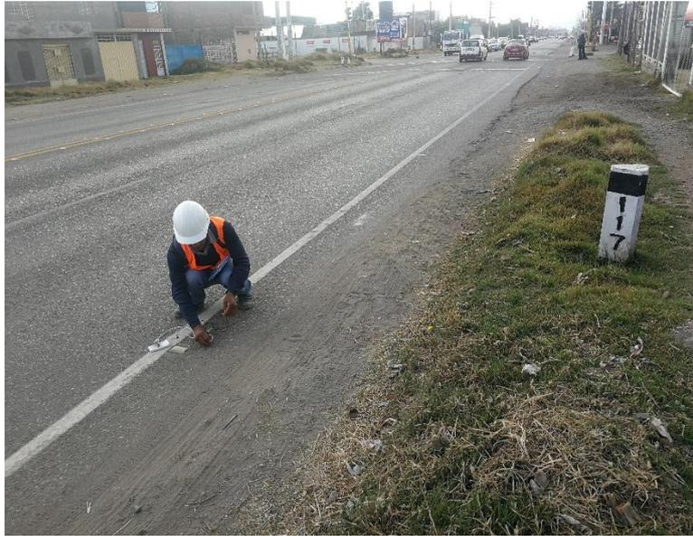
**Fotografía N°5:** Colocacion del dispositivo de temperatura
