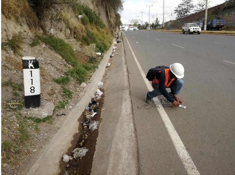
**Fotografía N°23:** Instalación y colocación del dispositivo de medición de la temperatura del pavimento
