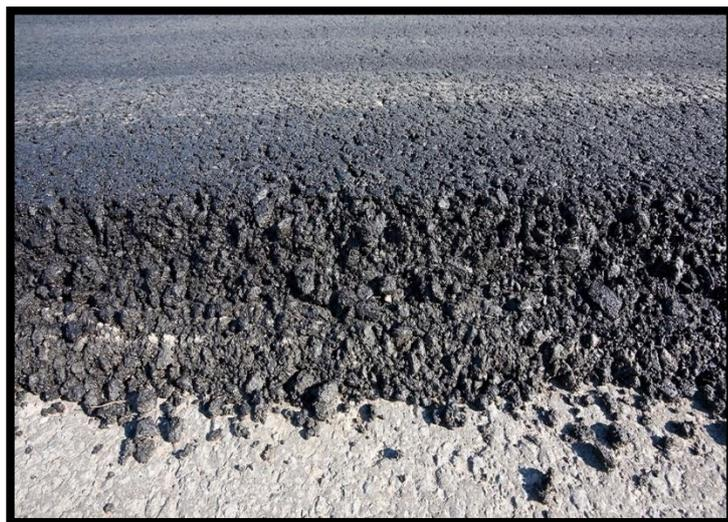
*Figura N° 5: Vista del espesor de carpeta asfáltica*
