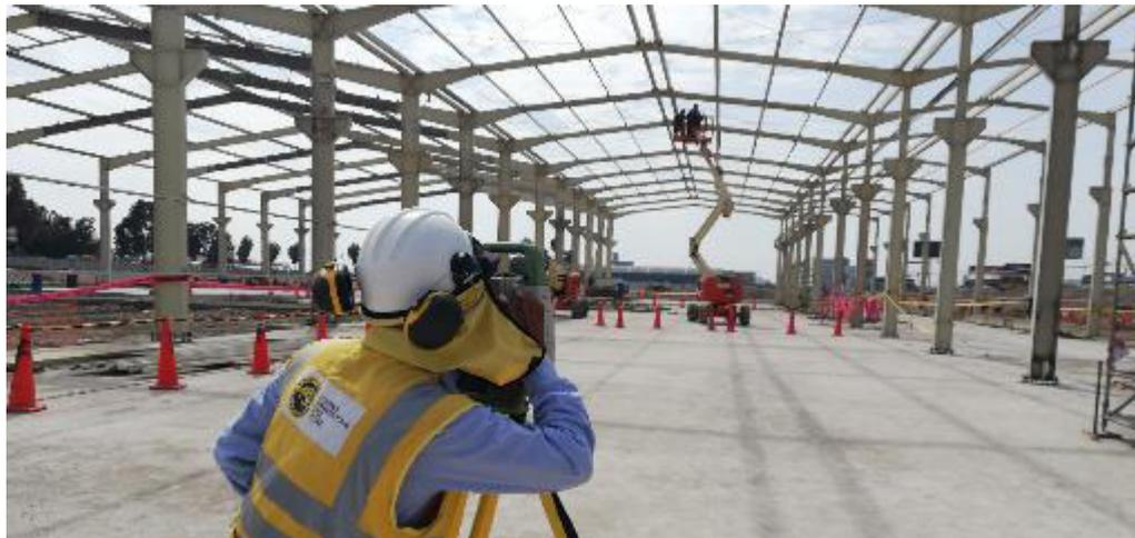
**Fotografía 16:** Control de Verticalidad y alineación de Estructuras prefabricadas
