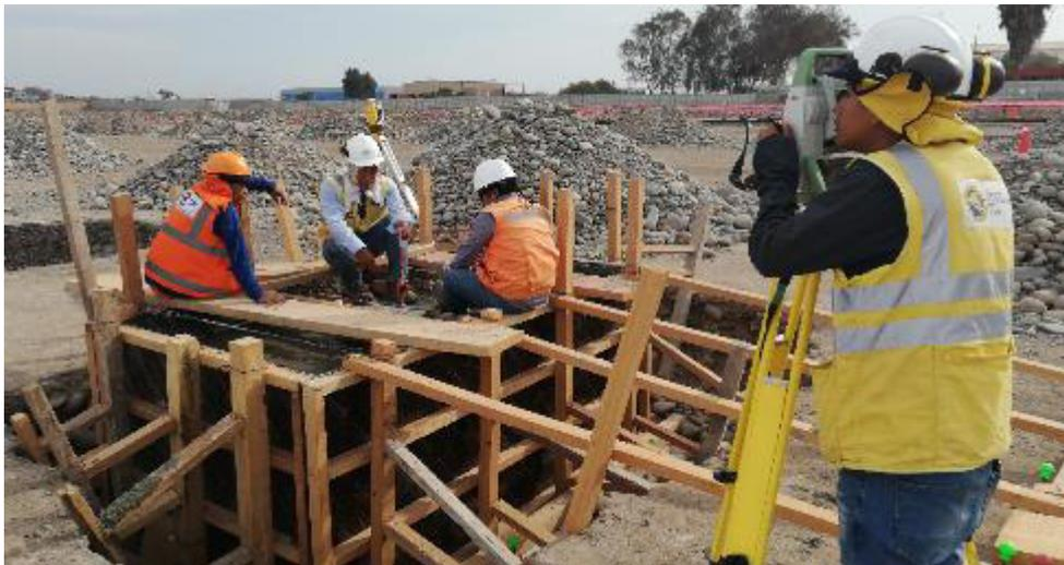
**Fotografía 12:** Verificación de posición de pernos de anclajes en concreto fresco
