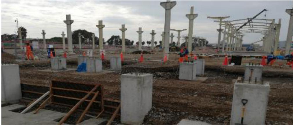
**Fotografía 15:** Pedestales y montaje de Planta de Concreto del Metro de La Línea 2
