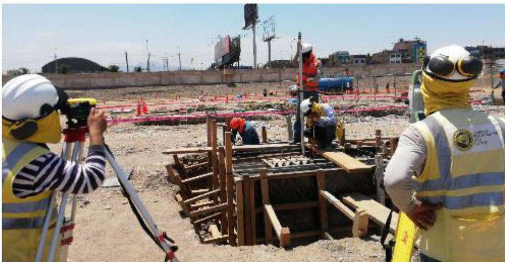
**Fotografía 11:** Verificación de niveles y posición de anclajes en concreto fresco
