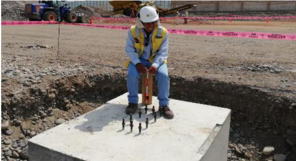
**Fotografía 13:** Levantamiento topográfico de la posición de pernos de anclajes
