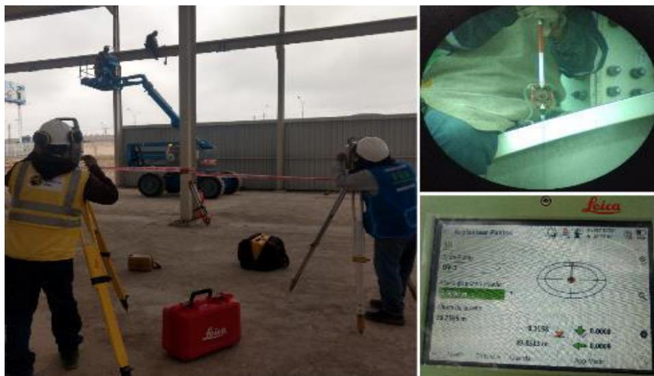
**Fotografía 14:** Control Geométrico Montaje de estructuras metálicas
