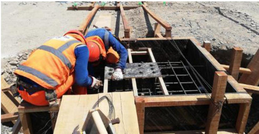
**Fotografía 7:** Instalación de los pernos de anclajes
