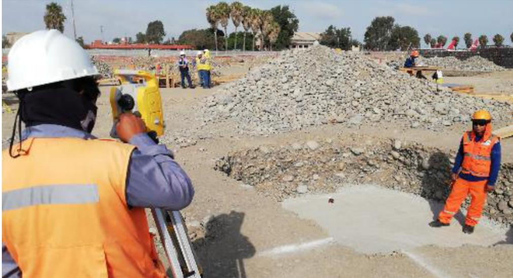
**Fotografía 5:** Trazo en solado para Encofrado de zapata
