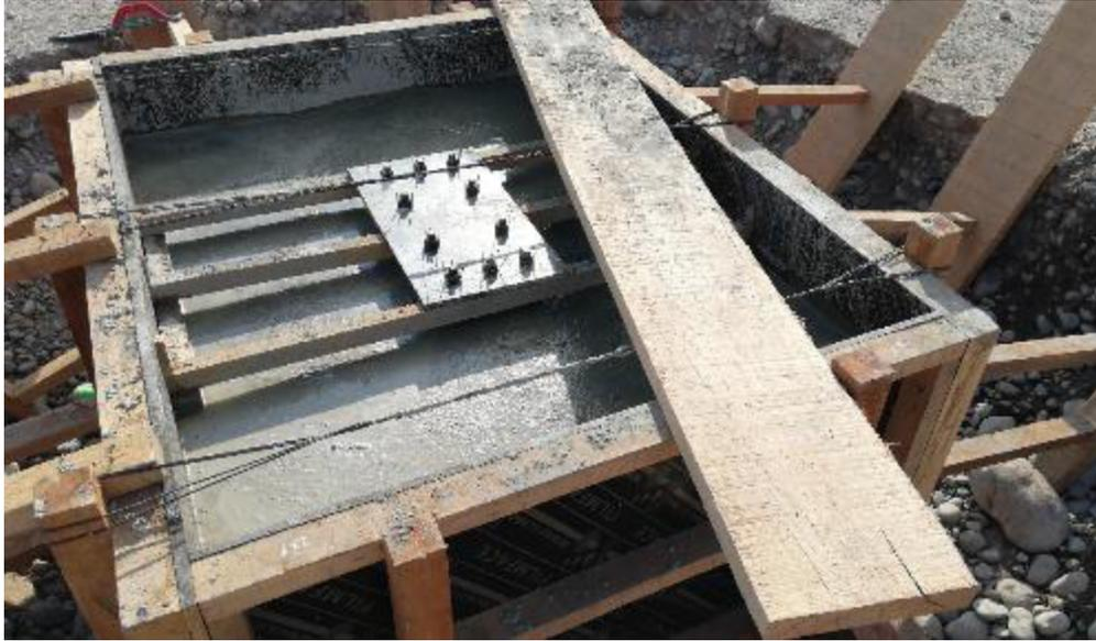
**Fotografía 10:** Pernos de Anclajes antes que Fragüe el concreto
