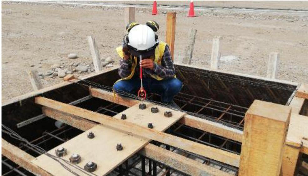
**Fotografía 9:** levantamiento topográfico de pernos de anclajes
