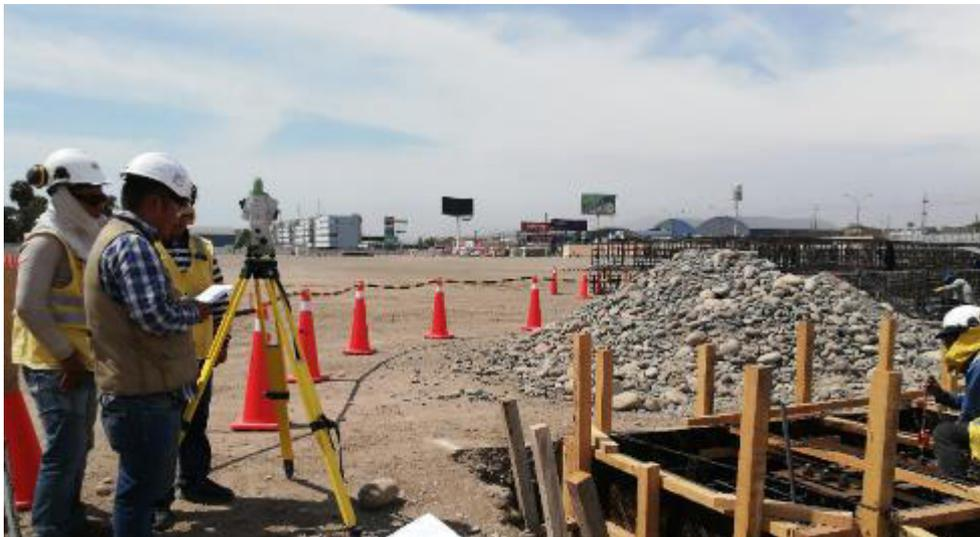
**Fotografía 8:** Verificación de posición de pernos de anclajes
