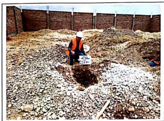
FOTO 03.- C-1, DISEÑO ESTRUCTURAL DE UN EDIFICIO DE VIVIENDA MULTIFAMILIAR DE CONCRETO ARMADO DE 15 PISOS Y TRES SOTANOS, AV. MARIATEGUI Nº 320
