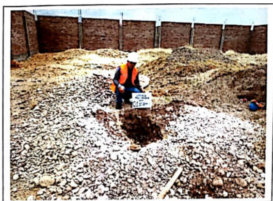
FOTO 01.- C-1, DISEÑO ESTRUCTURAL DE UN EDIFICIO DE VIVIENDA MULTIFAMILIAR DE CONCRETO ARMADO DE 15 PISOS Y TRES SOTANOS, AV. MARIATEGUI Nº 320
