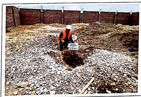
FOTO 02.- C-1, DISEÑO ESTRUCTURAL DE UN EDIFICIO DE VIVIENDA MULTIFAMILIAR DE CONCRETO ARMADO DE 15 PISOS Y TRES SOTANOS, AV. MARIATEGUI Nº 320
