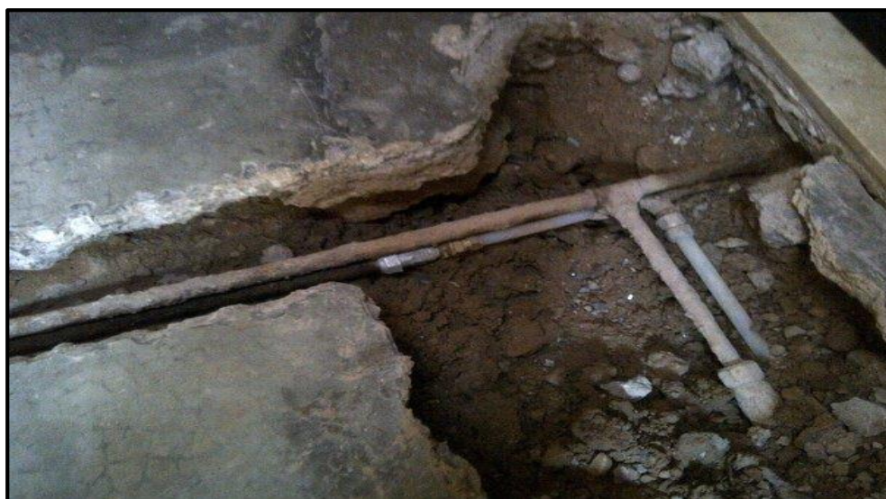
Fotografía 2: Instalaciones domiciliarias antiguas a base de tuberías de fierro galvanizado.
