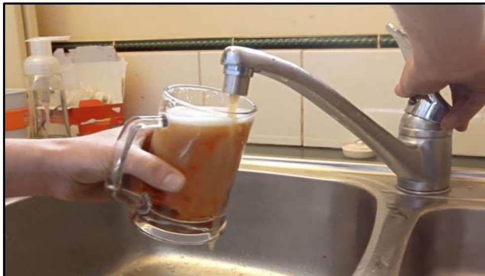
Fotografía 3: Agua contaminada con oxido, a causa de instalaciones con tuberías de fierro.
