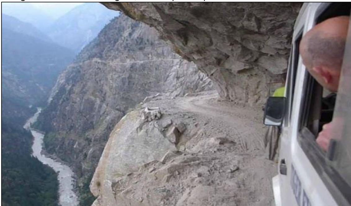
Fotografía 2: Camino inseguro, no cumple los parámetros técnicos de diseño.
