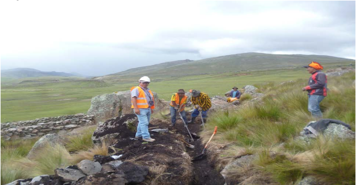
Fotografía 5: Excavación de la línea de conducción
