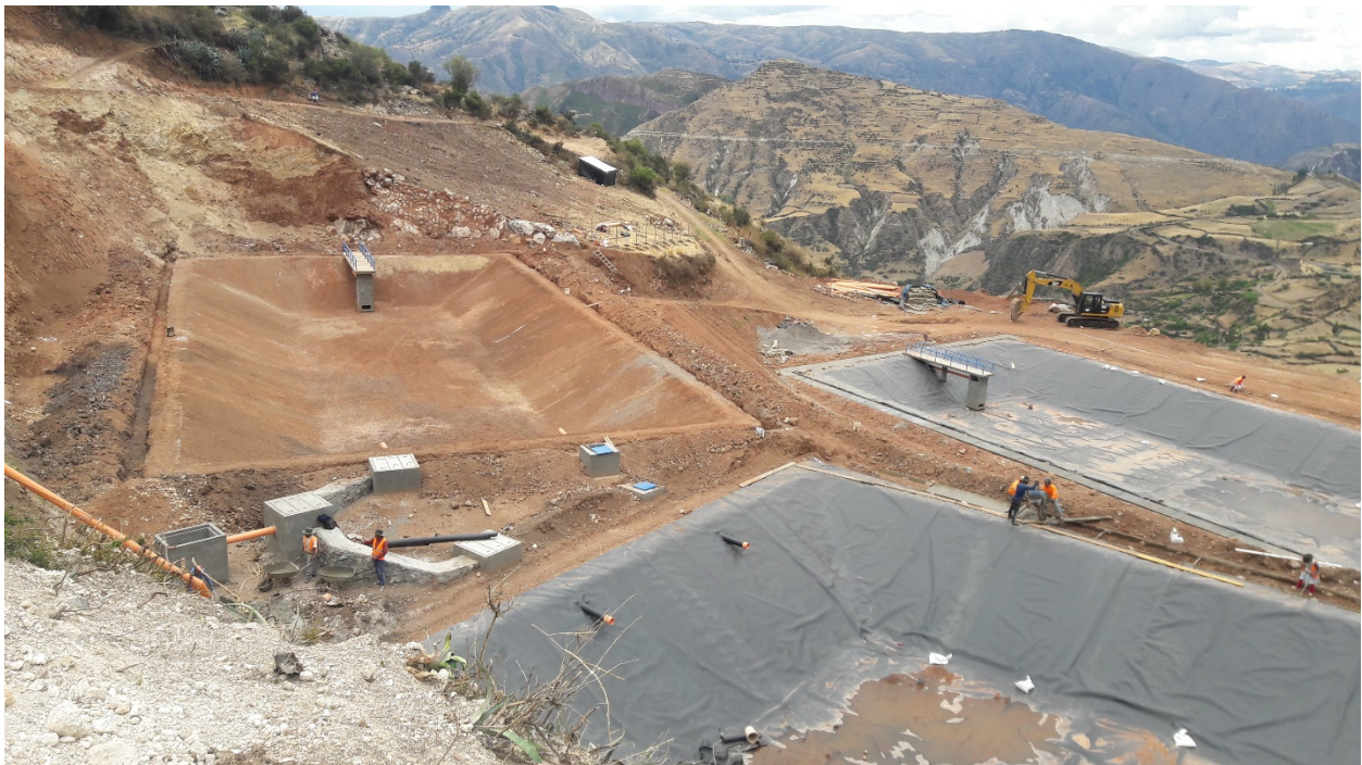
Fotografía 8: Proceso constructivo de PTAR
