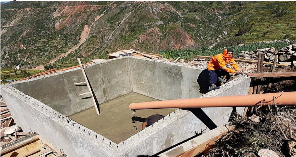
Fotografía 6: Proceso constructivo del reservorio de 25 m 3
