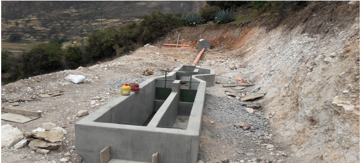
Fotografía 7: construcción de la cámara de rejas
