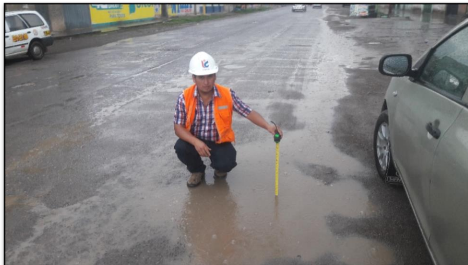
Fotografía N° 1: Verificación de drenaje en Área de Estudio
