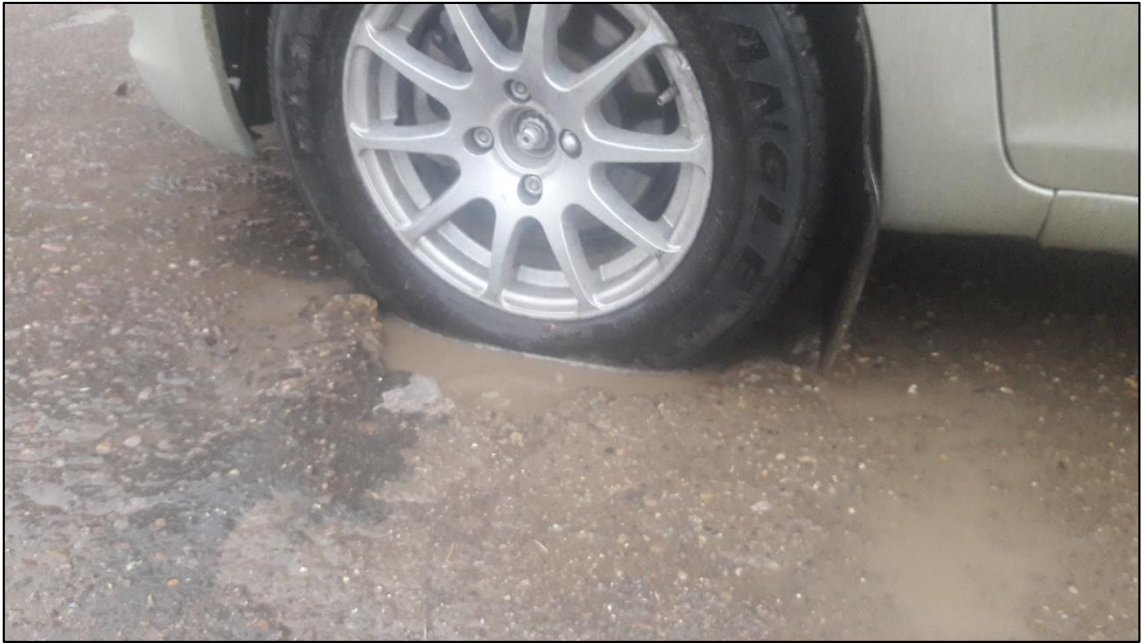
Verificación de servicialidad de pavimento
