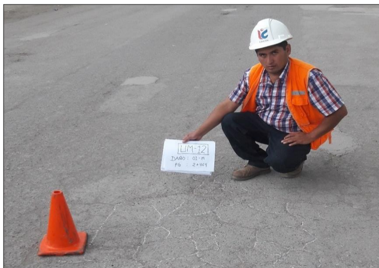
Fotografía N° 5: Análisis de Tipo de Falla por Unidad de Muestra
