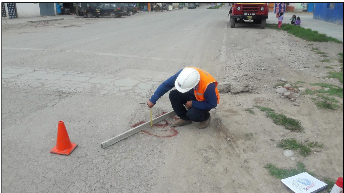
Revelamiento de fallas – Huecos Severidad media
