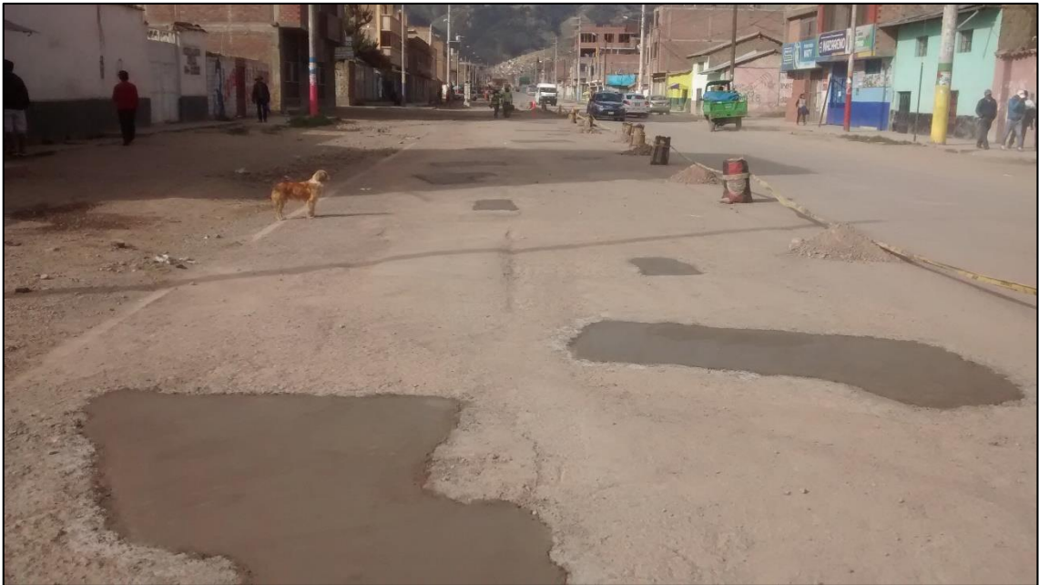
Trabajos de mantenimiento de pavimento flexible (Parcheo)
