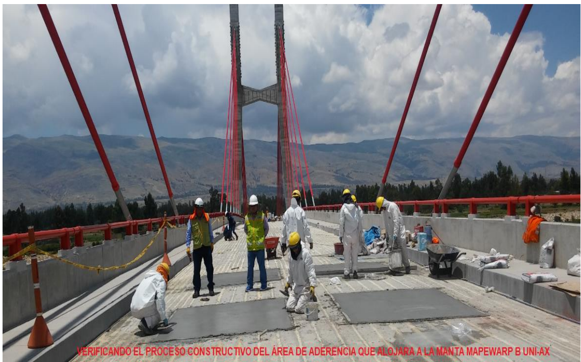
INSTALACIÓN DE MANTA MAPEWARP B UNI-AX EN LA PARTE SUPERIOR DE LA LOSA.
