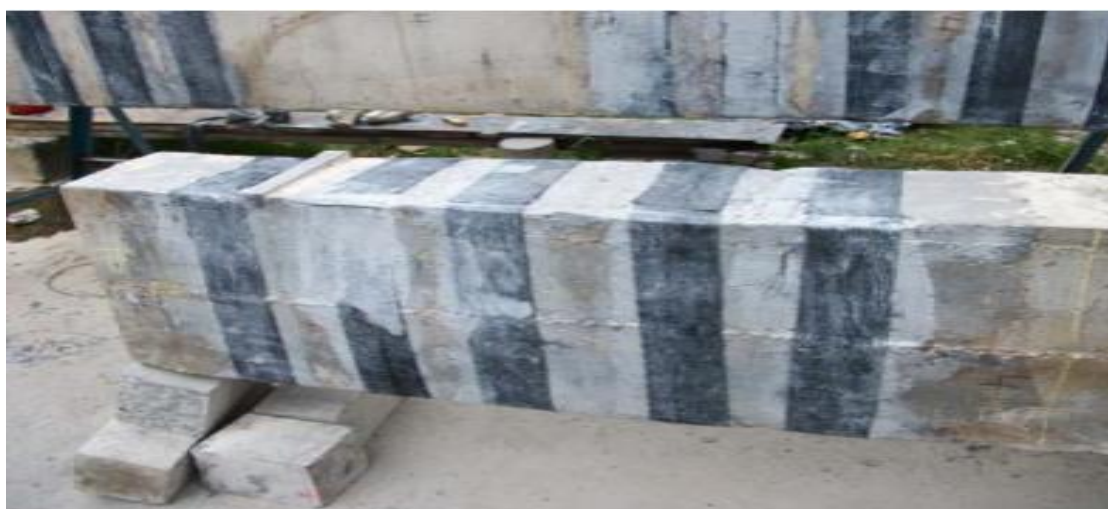
FIGURA 41 Instalación de Tiras de FRP a lo largo de la Vigas Preventiva Fuente Cárdenas Rincón
